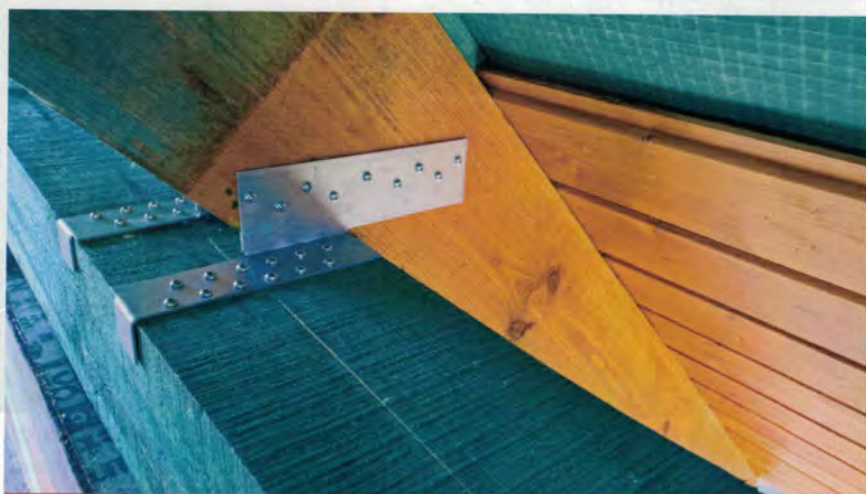
Zdj. 12. Złącza SFH stosowane w przypadku wiązarów rozporowych.
