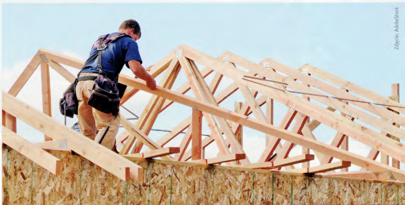
Zdj. 1. Montaż prefabrykowanych wiązarów dachowych.
