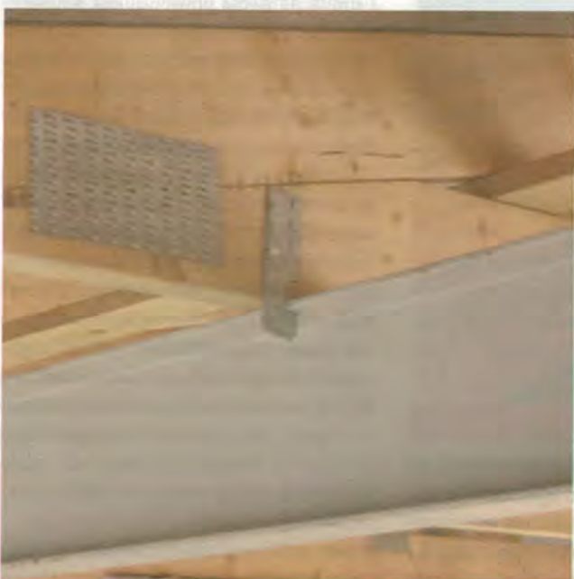
Zdj. 14. Oparcie więzara na dwuteowniku stalowym i połączenie kotwami HE.
