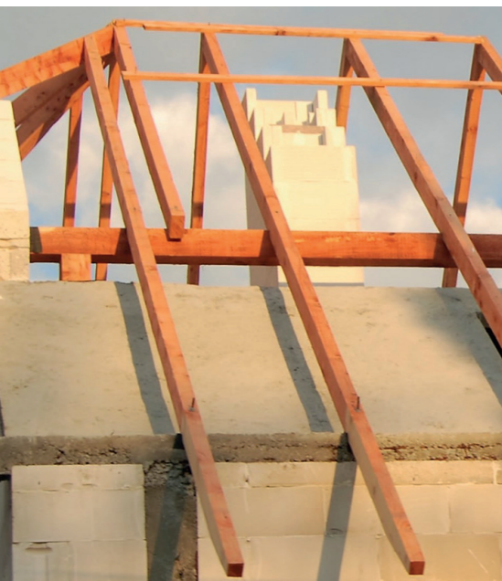
Fot. 2. Betonowe dachy
