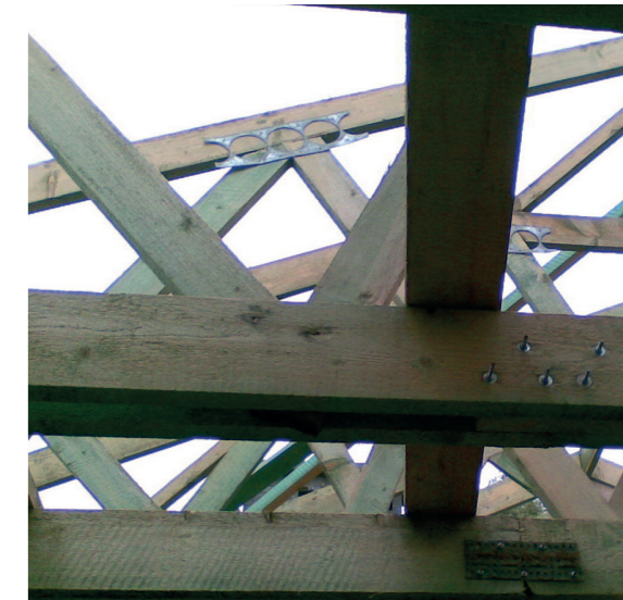
Fot. 4. Zastąpienie łączników odpadami blach
